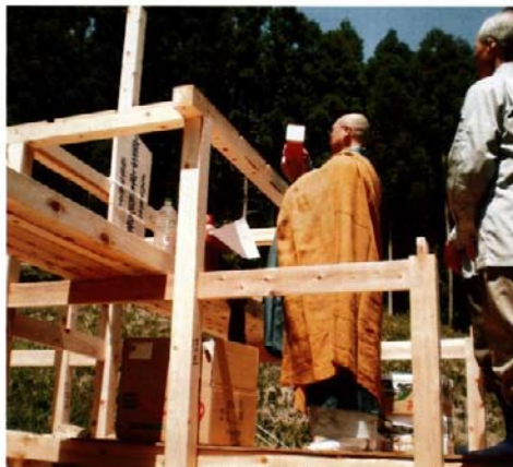
位牌堂の上棟式
